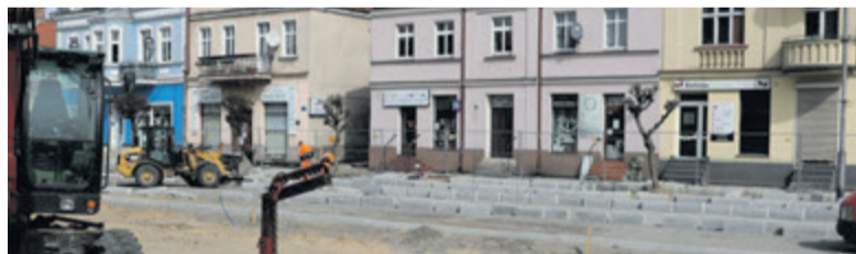
Drugi etap rewitalizacji – trwają prace ziemne
