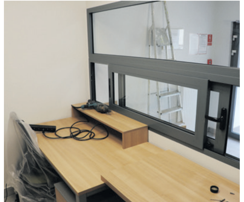
W nowej siedzibie Straży Miejskiej trwają ostatnie prace adaptacyjne
